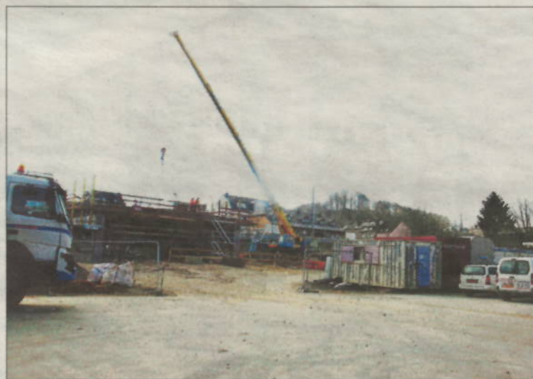
Die neue Ortszufahrt beginnt Form anzunehmen. Dadurch können auch die Bahnschranken abgeschafft werden. (FOTO: RAYMOND SCHMIT)
